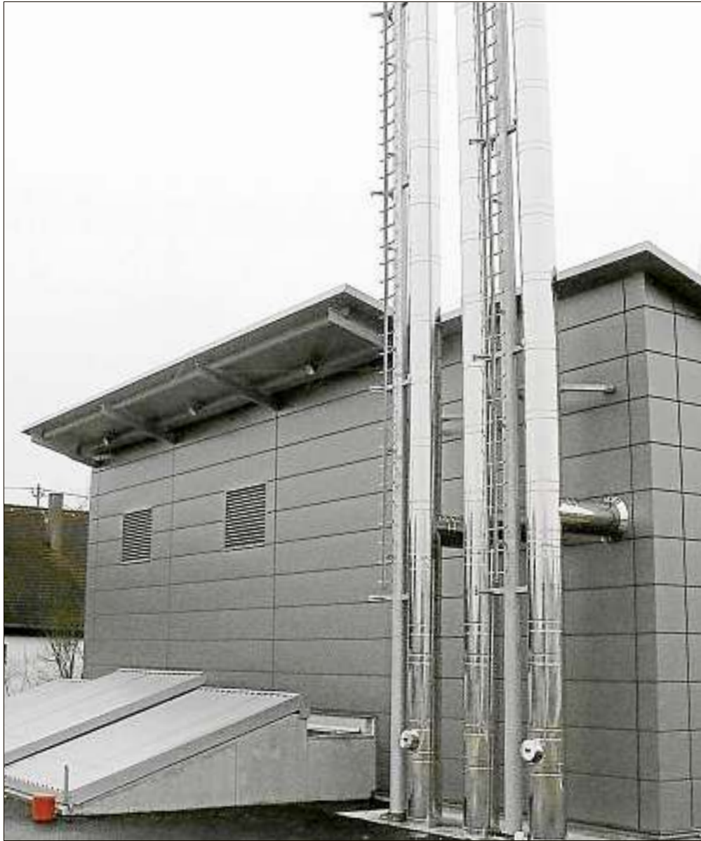
Die Kunden der Nahwärme müssen in Deißlingen 2017 und 2018 weniger zahlen. Foto: Archiv
